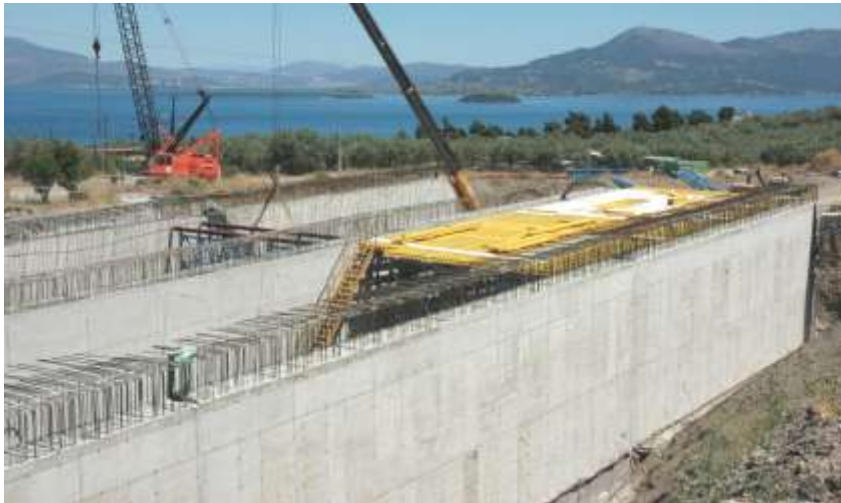
Τμήμα του Cut & Cover στη Χ.Θ. 11+824 σε φάση κατασκευής της οροφής
