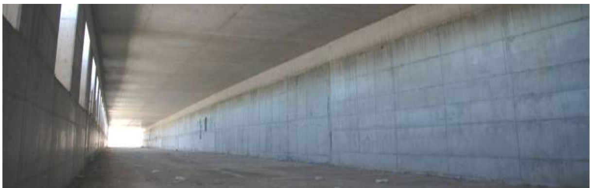
Αποπεράτωση κατασκευής οπλισμένου σκυροδέματος σήραγγας Cut & Cover μονής διατομής μήκους 450.0m από Χ.Θ. 14+540 - 14+950
